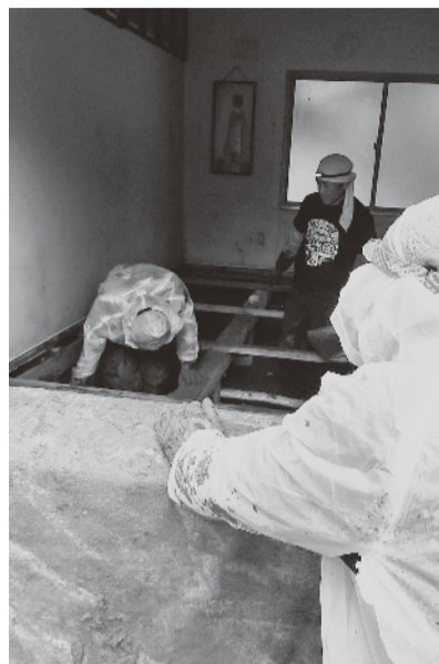
被災者宅の泥出し作業
