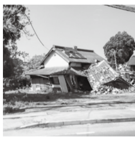
倒壊寸前の家
