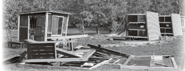
破壊され横転した森林公園内のバンガロー
