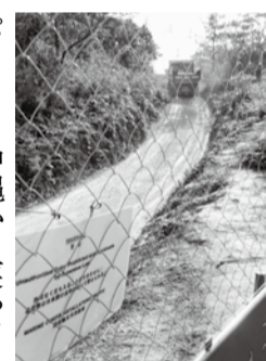
ゲート内に土砂 を運ぶトラック
