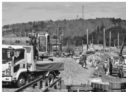
線路工事が進む富岡駅周辺
